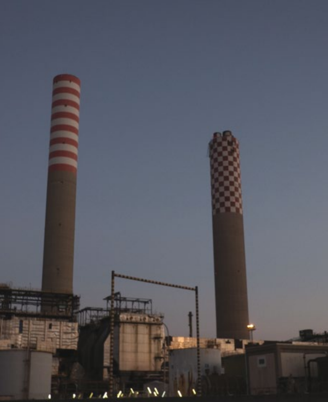
Gela, Centrale Termoelettrica. © Marzia Trovato, 2016
