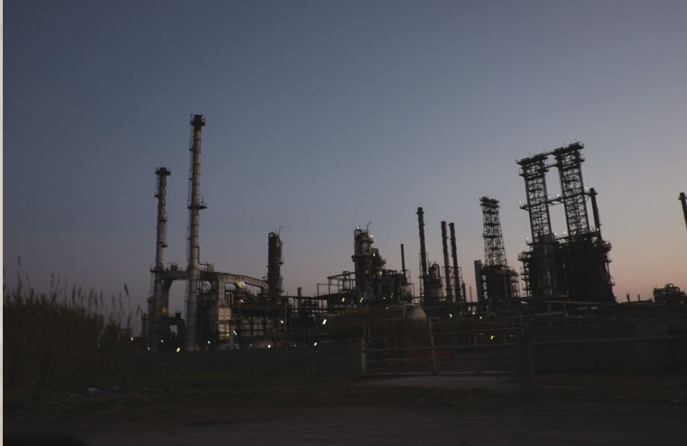
Gela, veduta notturna di impianti in disuso. © Marzia Trovato, 2016
