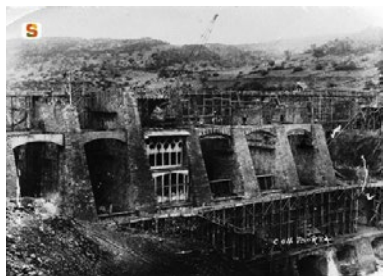
Figura 1. Costruzione della diga del Tirso. Fonte: Sardegna DigitalLibrary
