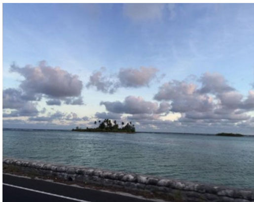
Kiribati, costruzione di pareti rocciose lungo le coste per salvaguardare l'atollo.
