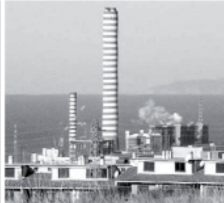
La centrale elettrica di Civitavecchia che funziona a carbone
